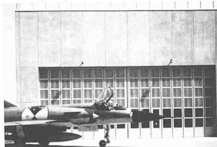
Arbeit hergestellt. Jedes der Tore wird durch 2 elektromechanische Antriebe in 35 Sekunden geöffnet oder geschlossen. Die Tore müssen bei jeder Witterung funktionieren, das heisst, sie haben zum Beispiel einer Windgeschwindigkeit von 180 km/Std. standzuhalten. Ein Tor wiegt 4800 kg und kann bei Stromausfall von Hand bedient werden.
