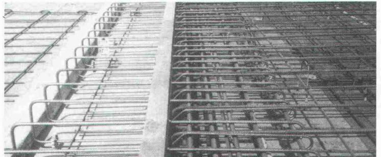
**ebea**® Kragplattenanschlüsse aus Ripinox erhöhen die Sicherheit
