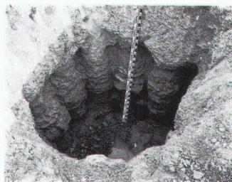
Das Gestänge wird zuerst auf die gewünschte Tiefe eingebohrt, dann bei gleichzeitiger Injektion langsam zurückgedreht. Der umliegende Boden wird vom strahlenartig austretenden Injektionsgut durchsetzt und zylinderförmig verfestigt.
