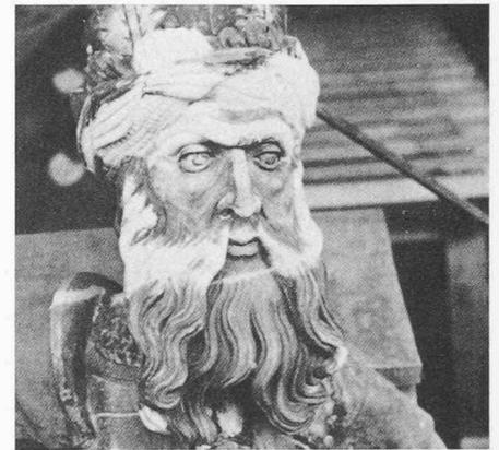
*Kopf des Pannerträgers am Zinnenkranz der Marktplatzfassade. Die hellen Stellen sind neue Aufmörtelungen, in einem Sanierungsverfahren mit rein mineralischem Mörtel, der ähnliche Eigenschaften aufweist wie der Sandstein*
