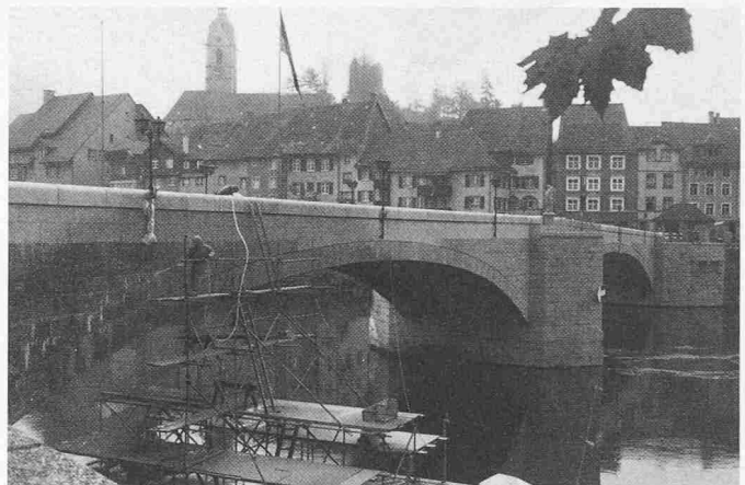
Bild 12. Reinigen der alten Aussenflächen
