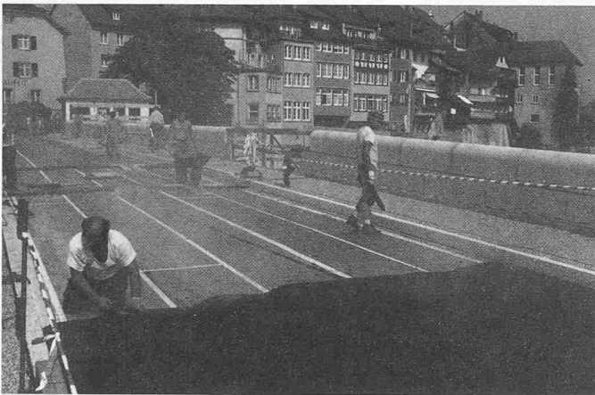
Bild 11. Aufbringen des Gussasphalts auf die Abdichtung
