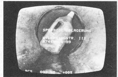
Bild 7. Kanalfernsehaufnahmen zur Beurteilung des Bau- und Betriebszustandes
