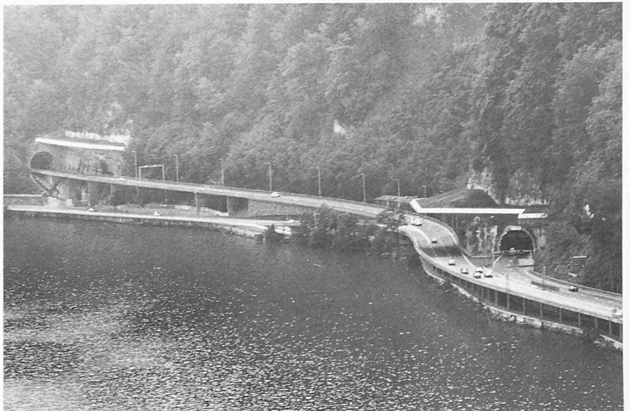
Bild 1. Steinschlagschutzbauten Lopper: Los 1 (rechts), über dem Westportal des Acheregg-tunnels Süd, Los 2 (links), über dem Westportal des Acheregg-tunnels Nord
