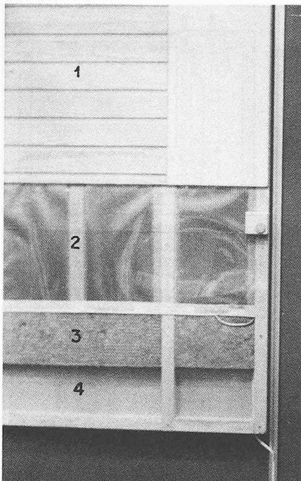
Elektrische Heizfolie. 1 Innenraum-Holztafer, 2 Heizfolie, 3 Wärmedämmung, 4 Mauerwerk
