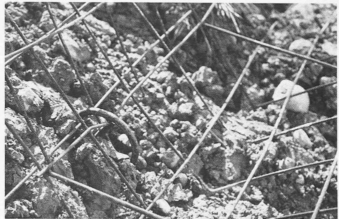
Das abgerutschte schlechte Material wurde ausgebaggert. Hangparallel wird ein dreidimensionales Gitternetz befestigt, das die biotechnische Hangsicherung in den ersten Jahren ergänzt
