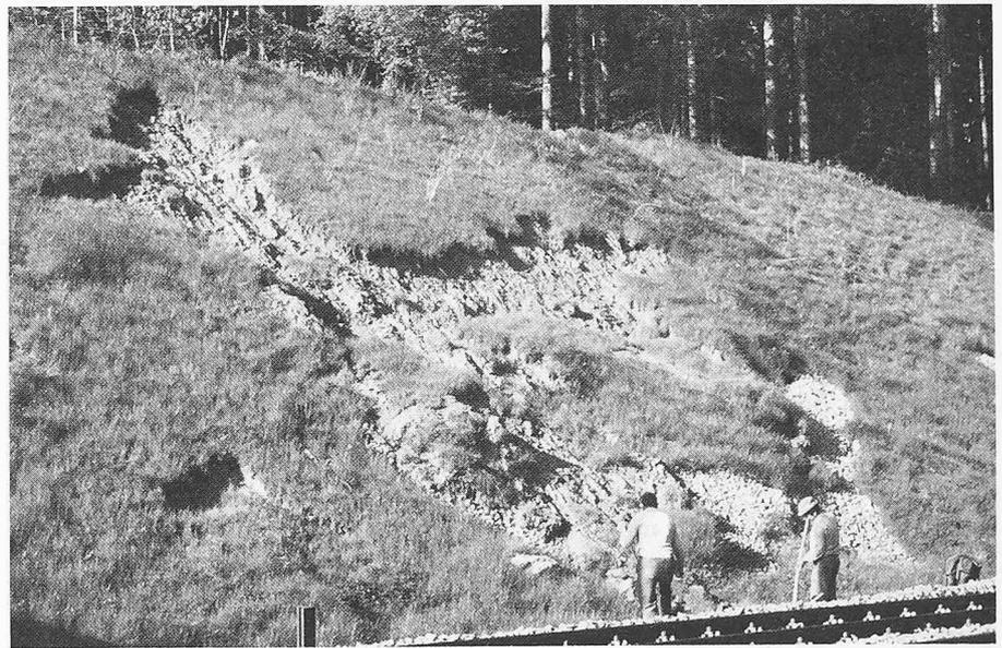
Durch die Einwirkung von Eis und Schmelzwasser wurde die Vegetationsschicht im Frühjahr 1981 wie ein Fell abgeschält. Sie übermurtete die Sickerpackungen am Böschungsfuss
