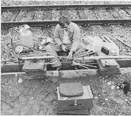
Bild 10. Kabelmonteur bei der Spleissarbeit
