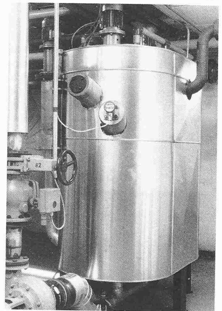
Bild 1. Sulzer Schlamm/Schlamm-Wärmetauscher
