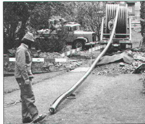
10.04 Die Verlegung der FLEXWELL-Leitung beginnt...
