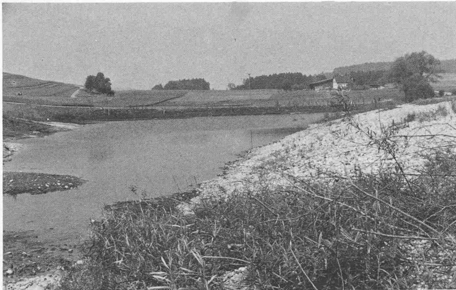
Hochwasserrückhaltebecken Chefikon an einem Seitenfluss der Thur bei Ellikon a. d. Thur (ZH). Übersicht
