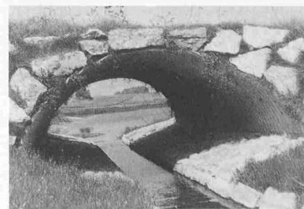
Hochwasserrückhaltebecken Chefikon. Durchsicht aufs Becken mit Brücke über dem Einlauf
