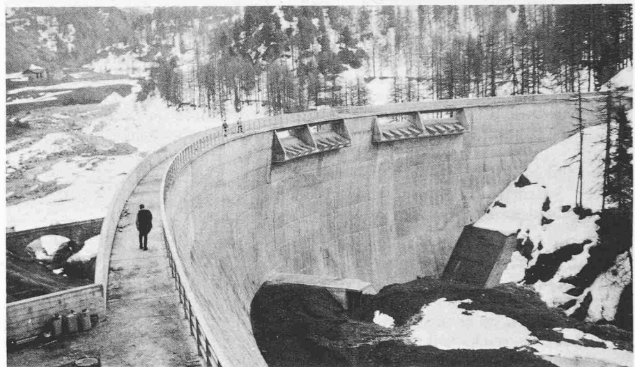
Staumauer Orden an der Orlegna im Bergell (GR). Ansicht von der Luftseite
