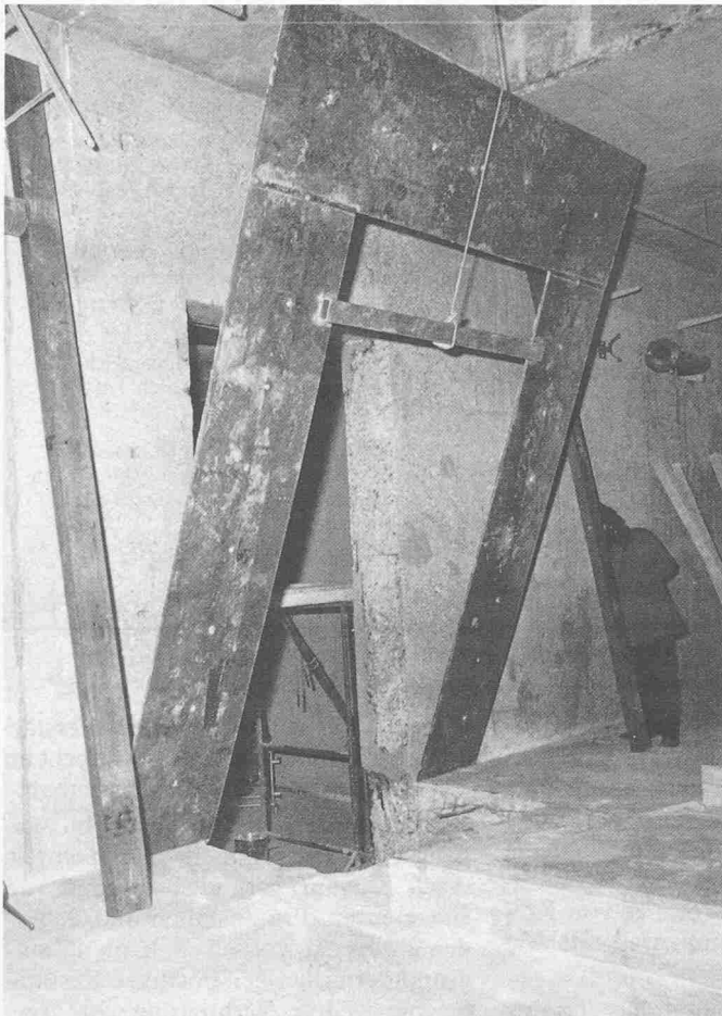
Bild 9. Als Verstärkung einer nachträglich ausgebrochenen Öffnung werden beidseits Flachstahlrahmen auf die Betonwand geklebt
