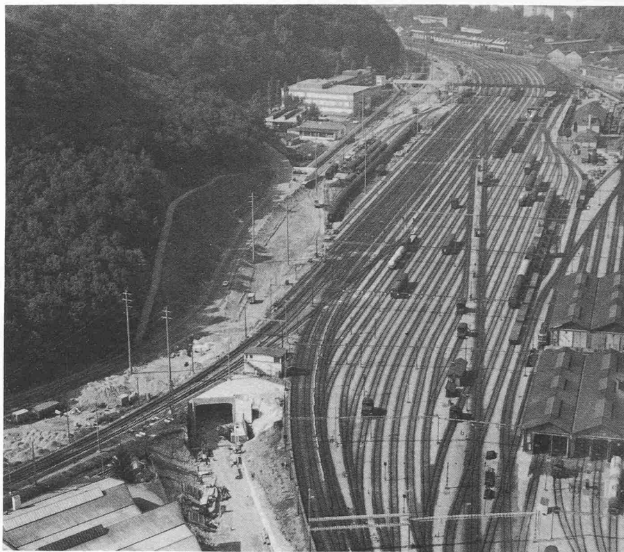
Bild 4. Luftaufnahme der Gleisanlagen nördlich des Personenbahnhofes Olten. Links neugestalteter Hangfuss des Hardchopfes, davor Nordportal Überwerfungsbauwerk/Tannwaldtunnel
