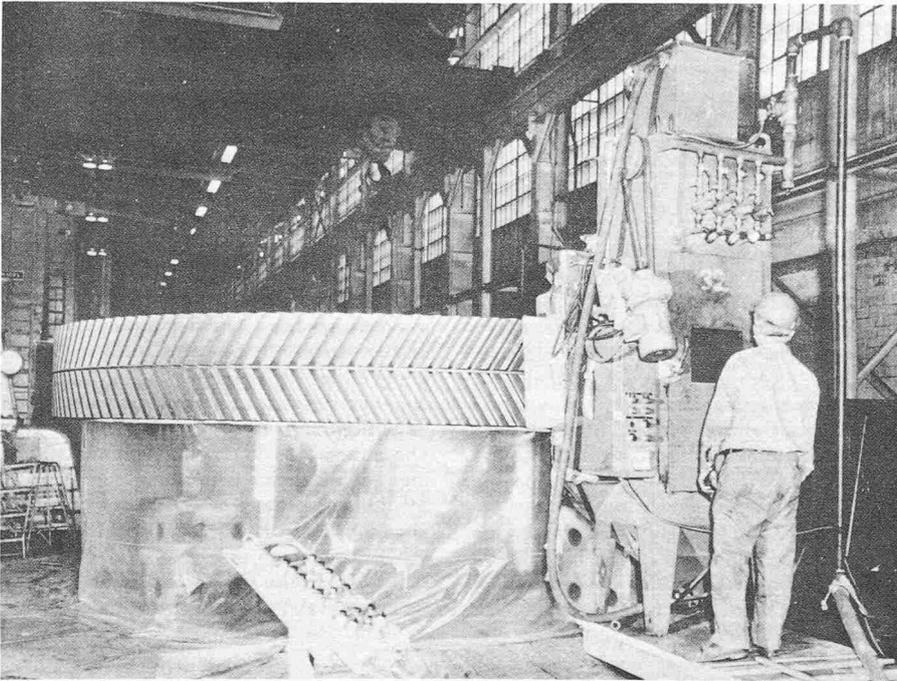
Bild 30. Shot-peenen eines grossen Zahnrades von 7100 mm Durchmesser. Auswärtsarbeit. Nach dem Druckluftsystem arbeitende, als semi-portable bezeichnete Spezialausrüstung. Sie ist mit vier in der Strahlkabine eingebauten, eine vertikale Hin- und Herbewegung ausführenden Injektor-Strahlpistolen ausgerüstet, währenddem die Strahlmittelzufuhr mittels Becherwerk nach dem Gravitationssystem erfolgt. Zusätzliche Abdichtungen: Plastiktücher.
