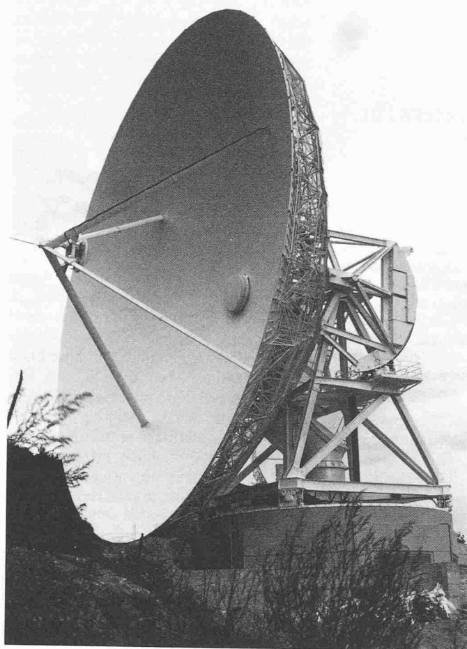
Bild 1. Ansicht der Rad-Schiene-Antenne (Wheel and Track) der PTT-Bodenstation Leuk nach Beendigung der Montage
