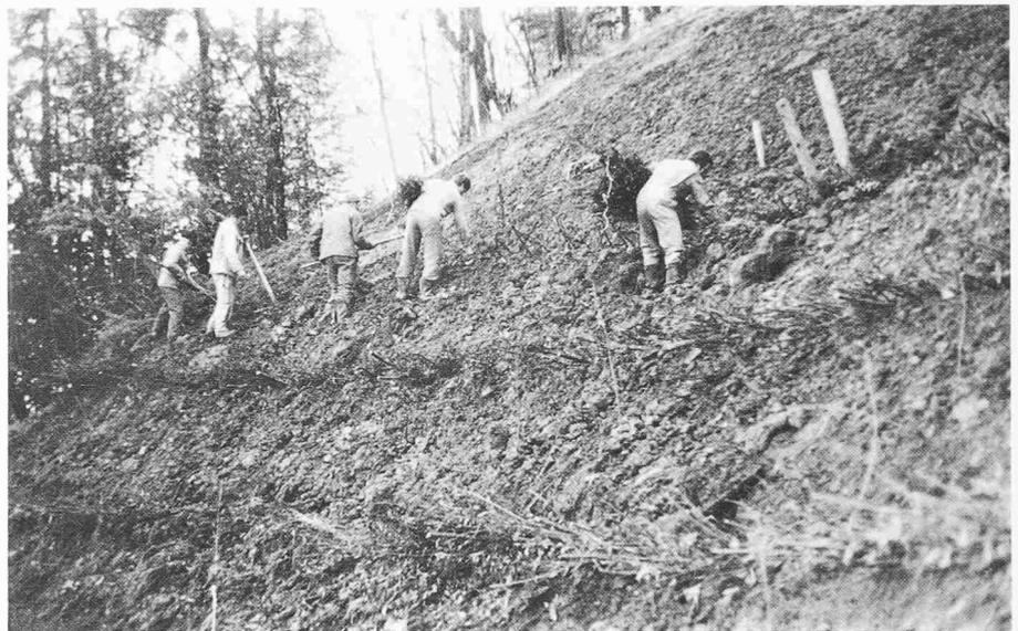
Bild 9. Schlupf. Der Schlupf wird von unten nach oben mit Buschlagen verbaut. (kombinierte Bauweise)
