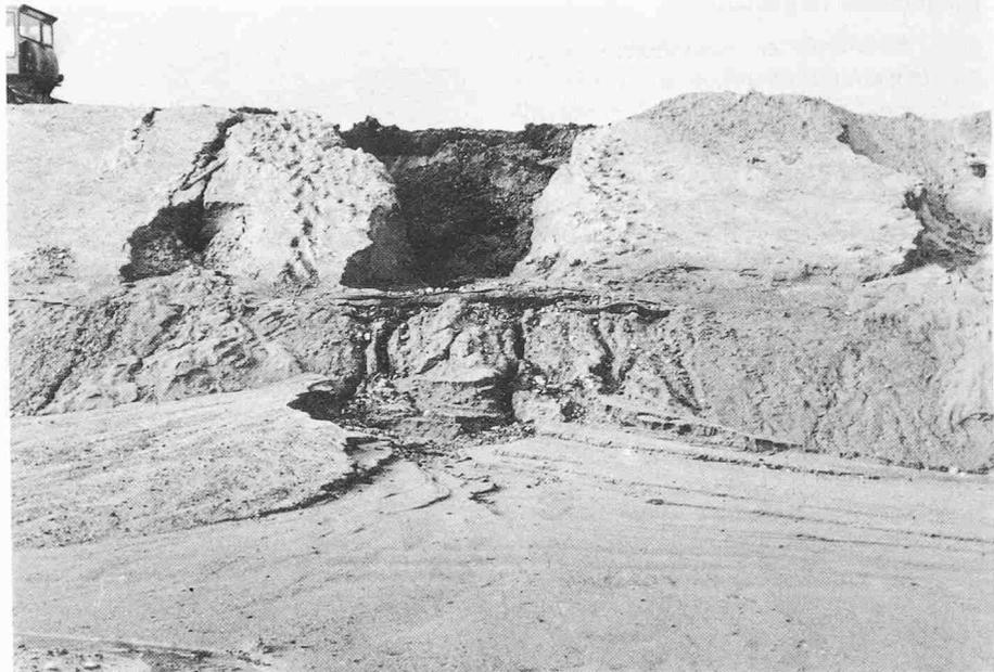
Bild 12. Kerzers N1. Starke Niederschläge verursachten tiefe Erosionsrinnen in den angeschnittenen Böschungen
