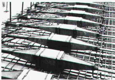
Vorfabrizierter Träger mit beweglicher Verankerung Typ A 2350
