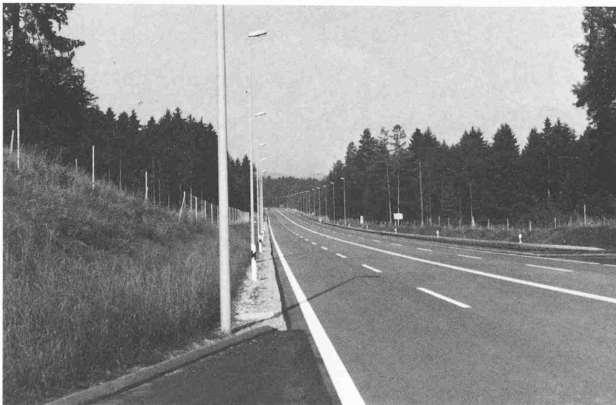
Bild 2. Anordnung der Beleuchtung auf der verlängerten Forchstrasse, Lichtpunkthöhe 12 m, Lichtpunktstand 30 m
