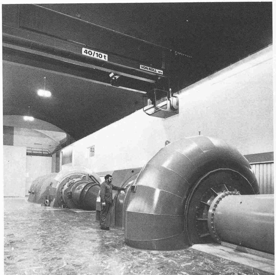
Fig. 7. Pont roulant 40/10 t (portée: 11,10 m): Vue partielle avec cabine de commande vitrée (le câble pour la commande au sol est visible, enroulé contre une paroi de la cabine)
