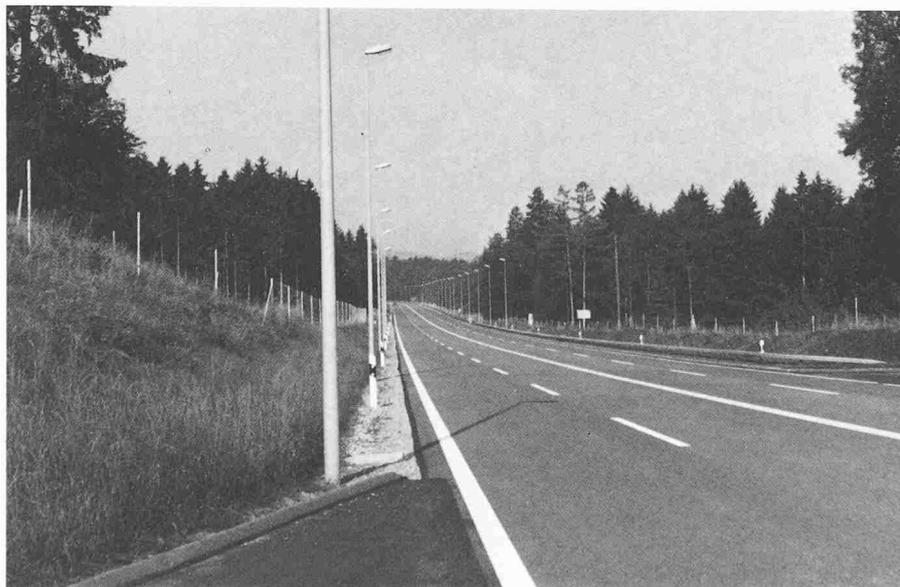
Bild 2. Anordnung der Beleuchtung auf der verlängerten Forchstrasse, Lichtpunkthöhe 12 m, Lichtpunktabstand 30 m
