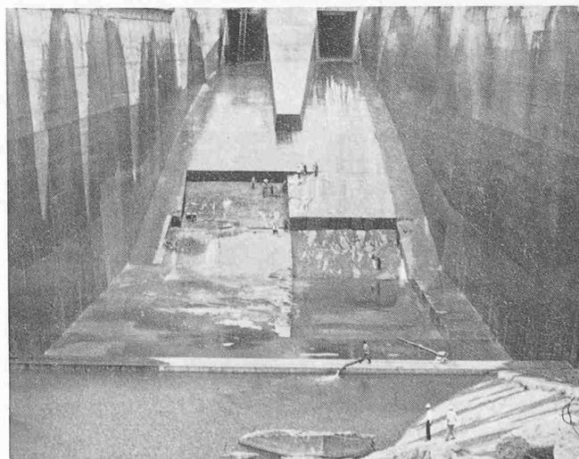
Bild 4. Nach 17 Stunden Probetrieb wurden 1976 erneut 2000 m<sup>3</sup> Beton weggetragen und weiter unten (vorne im Bild) abgelagert
