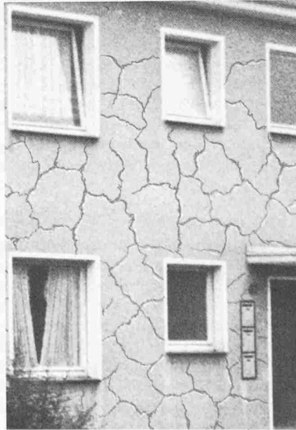
Bild 3. Spannungsrisse
