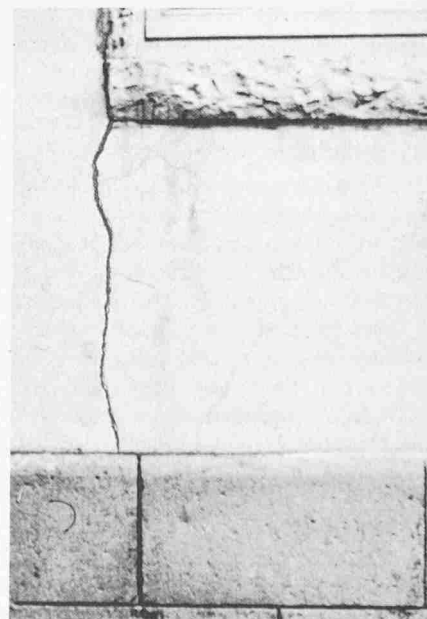
Bild 5. Thermische Risse
