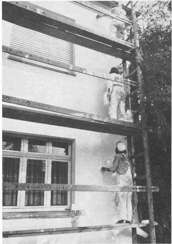
Bild 6. Einlegen des Elastic-Gewebes in den Armierungskleber
