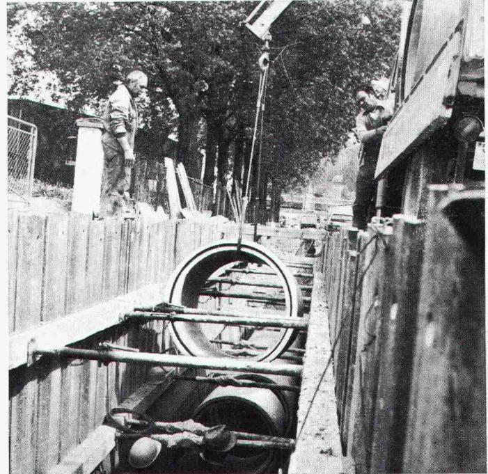
Abladen und Einsetzen von Betonröhren mit einmontierten «BFL-Mastix»-Bändern
