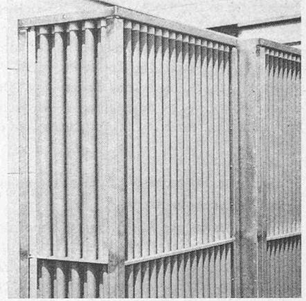
Bild 3. Luftaufbereitungszentrale mit eingebautem Röhrenwärmeaustauscher im Hallenbad Winterthur
