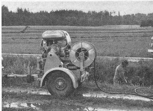
Bild 8. Spülung eines Dränsaugers von der Grabenausmündung her mit «Hydromat-Hochdruckreinigungsgerät Birchmeier Titan-BH-III». Wasserentnahme (rd. 70 l/min) aus dem Vorfluter oder Zufuhr mit Druckfässern [13], [14]
