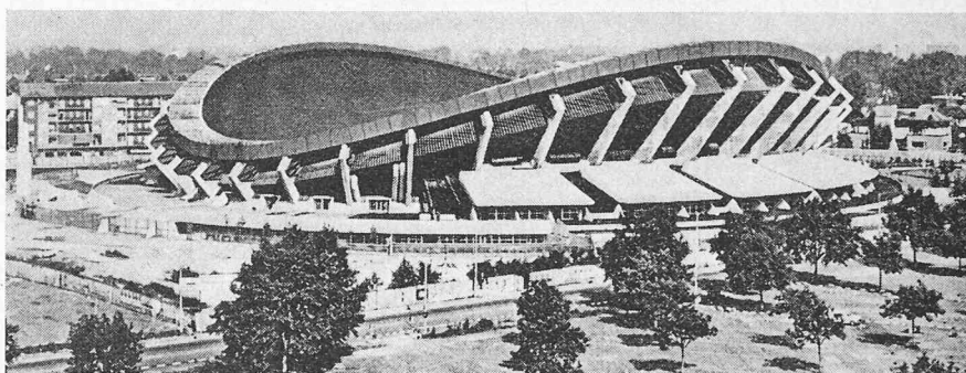
Bild 2. Bauherr C. O. N. I., Architekten: G. Valle und T. Talle, Ingenieur: G. Romaro, Stahlkonstruktion: Comeva, Vicenza, Kabel: H. F. C. D. des Trafileries et Câbleries. Begründung: Ein ausgezeichnetes Vorbild für Harmonie von architektonischen Anforderungen und Konstruktionsmethoden, die zu einem originellen und beeindruckenden Bauwerk geführt hat, das seinem Zweck voll gerecht wird. Die Dachkonstruktion mit ihren aussergewöhnlichen Abmessungen ist nach modernsten Methoden errechnet und geplant
