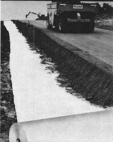
SODOCA-Vlies aus UV-stabilisiertem Polypropylen trennt, filtert und verteilt die auf die Strasse wirkenden Kräfte im Unterbau. SODOCA verkauft Ihnen nicht irgendein Vlies, sondern für die verschiedensten Problemstellungen im Tiefbau jeweils spezielle Vliesstoffe: zum Beispiel für Strassenbau, Gleisbau, Baustrassen, Forstwege, Flugpisten, Drainage... Mit SODOCA sparen Sie Zeit. Und Zeit ist Geld. Denn mit SODOCA bauen Sie bei jeder Witterung: rationeller und schneller.
