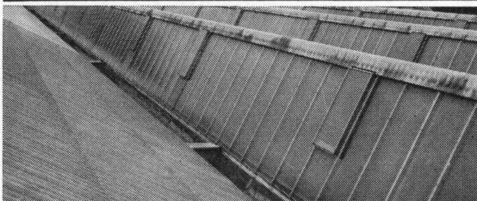
Kittlose Industrieverglasung von Tuchschmid als Shed- oder Satteloberlicht, Fassadenlichtband oder Vordach.
