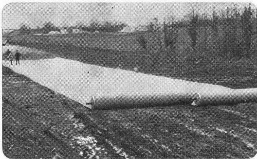
Abrollen der Matte, Vorkopf- aufschüttung
