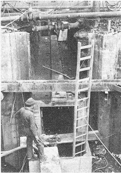
Bild 7. Auflagerwand Süd mit eingeschobener letzter Elementreihe und erfolgtem Aushub für den Auflagerkopf in Ortsbeton. Im Vordergrund der Zugang zu den unteren beiden Elementreihen
