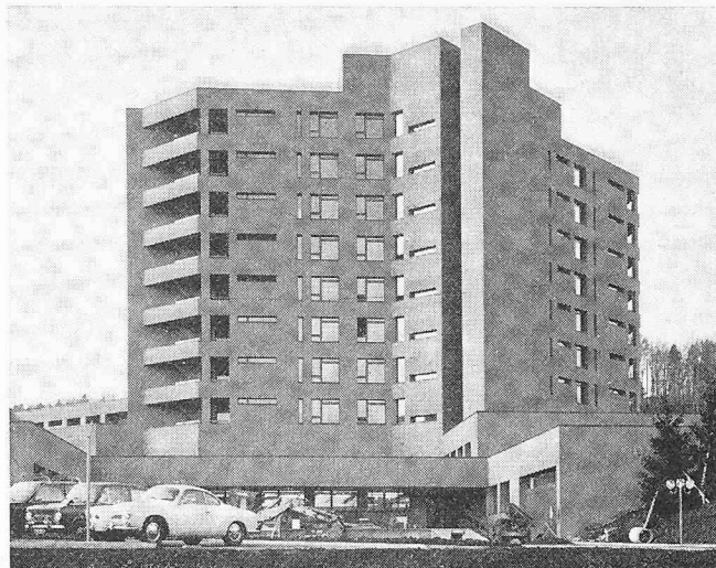
Bettenhaus von Südosten mit Wirtschaftshof
