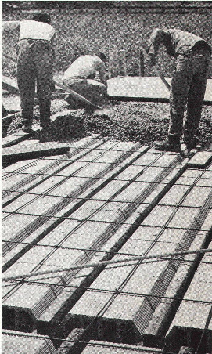
Dieses vorfabrizierte, ab Lager lieferbare Elementsystem eignet sich im Hochbau besonders für Hohlraum- und Kellerdecken. Die vorgespannten Betonbalken und die Tonhourdis übernehmen die Funktionen der Deckenschalung und der Hauptarmierung.
