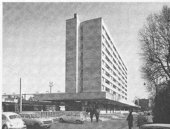
Das Aufnahmegebäude von Westen
