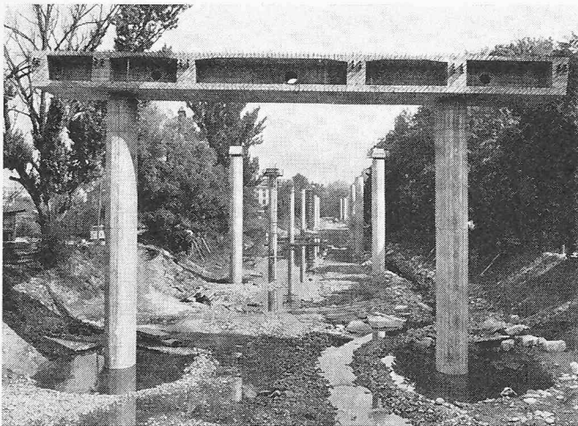
Bild 2. Im Flussbett der Sihl erstellte Hochstrassenpfeiler
