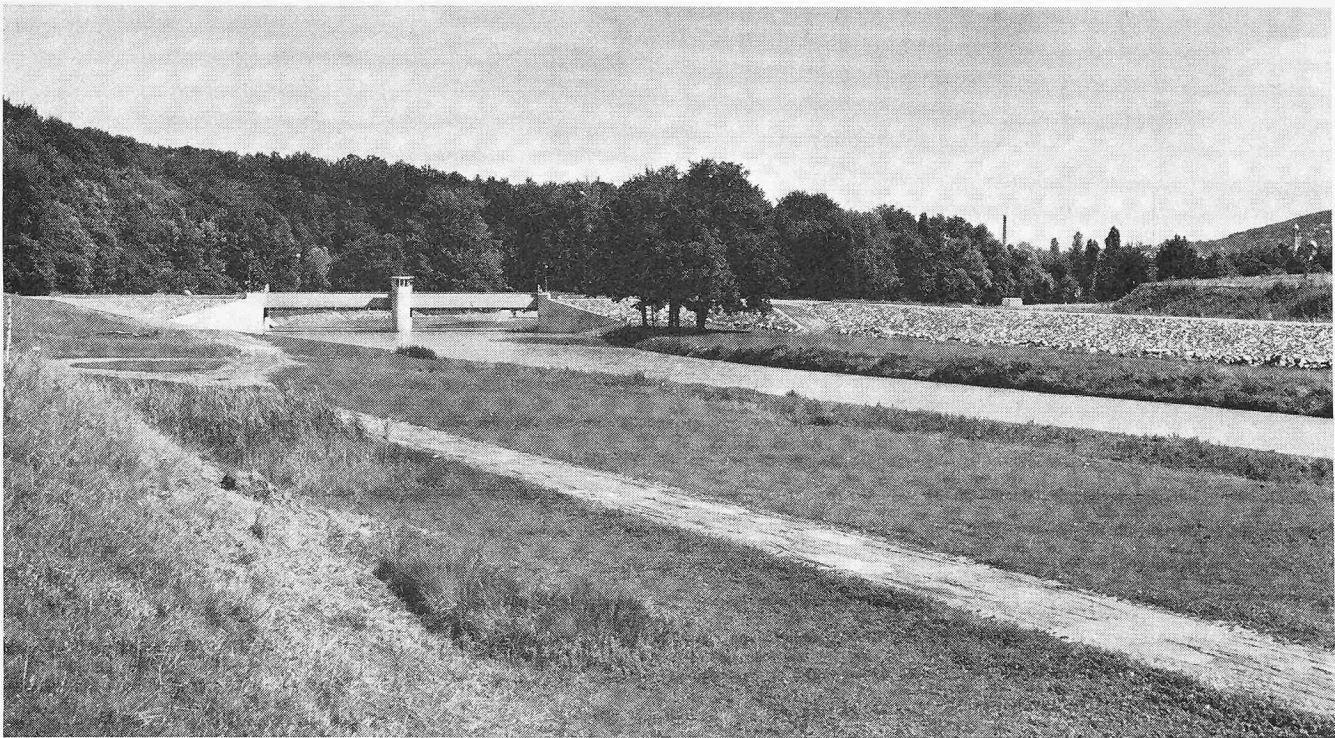
Bild 13. Fertiggestelltes Eisretentionsbecken mit zwei 20 m breiten Wehrröffnungen und hochgezogenen Schützen (Sommerstellung. Die Verschlusskonstruktionen sind harmonisch ins Landschaftsbild eingepasst
