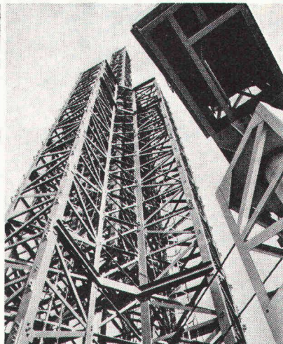
Die Stahlkonstruktion ist in der Endlage auf 185 m Höhe angelangt.
