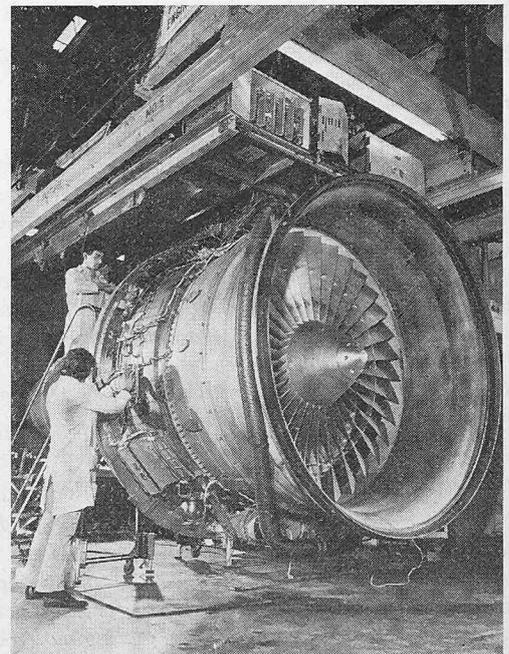
Bild 15 (rechts). Das Triebwerk RB. 211-24 wird für die Prüfstandsversuche vorbereitet
