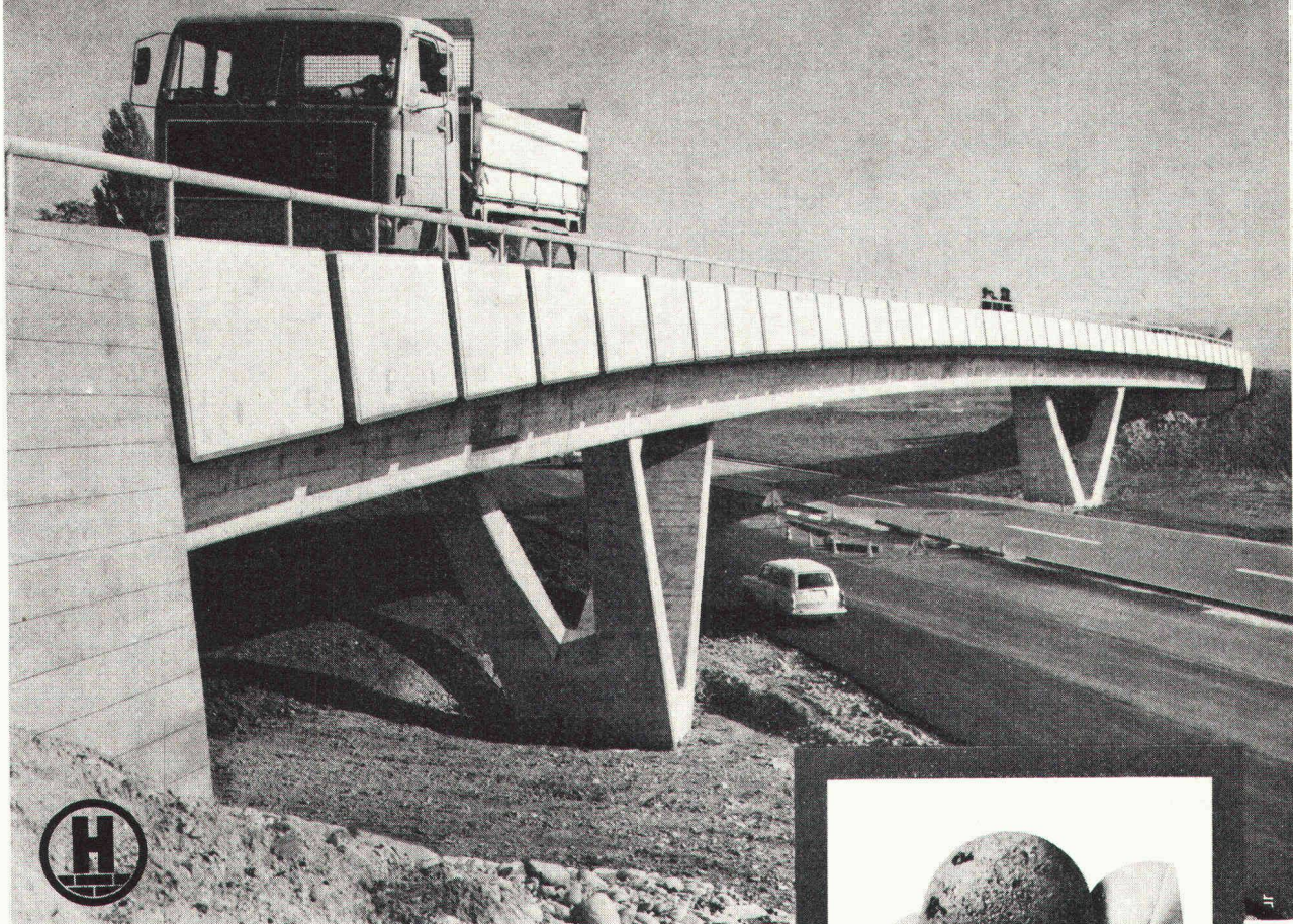
Brücke aus Leca h 2 d 2 -Beton beim N 4-Anschluss (Mutzentäli), Schaffhausen Bauherr: Tiefbauamt des Kantons Schaffhausen Statik: Wehrli & Weimer, dipl. Bauing. ETH/SIA, Zürich Bauausführung: B. Ehrat-Osswald, Baugeschäft, Neuhausen am Rheinfall
