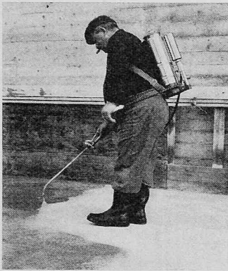
Bild 5. Aufsprühen des Decken-trennmittels
