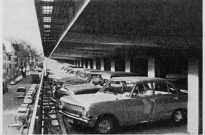
Bild 13. Die zwischen den Parkplätzen angeordneten Stützen gewähren einen komfortablen Zwischenraum zwischen den Fahrzeugen
