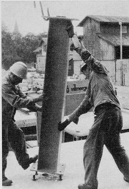
Bild 6. Absetzen der Stahlstützen auf genau horizontalisierte Stellmuttern
