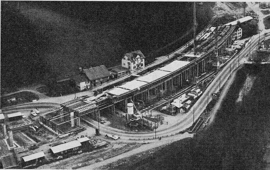
Bild 26. Flugaufnahme der Bauetappe 1. Beginn der Betonierarbeiten auf der rechten Brückenhälfte, November 1964 (Photo Swissair)
