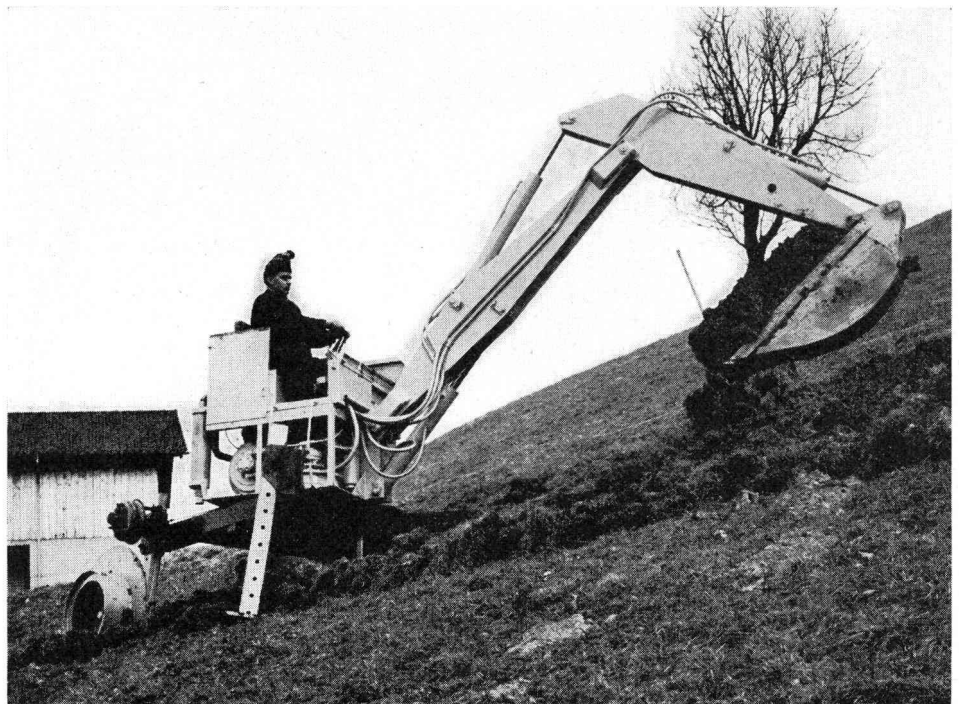
So arbeitet der MUK 3000 am Hang.
