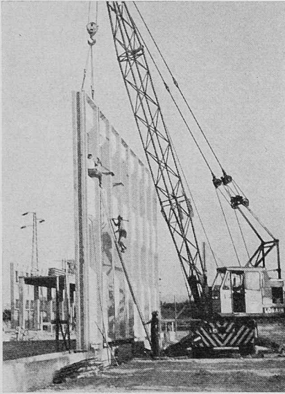
Bild 17. Montage von dreigeschossigen Aussenwänden zum Verwaltungsbau
