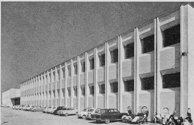
Bild 16. Verwaltungsbau mit tragenden, über mehr Geschosse hindurchgehenden Wandtafeln
