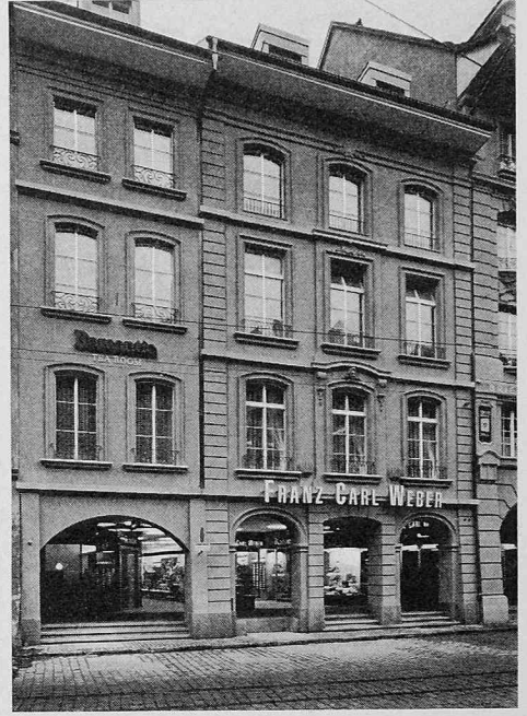
Bild 9. Marktgasse 52. Fassade nach der Wiederherstellung, 1960
