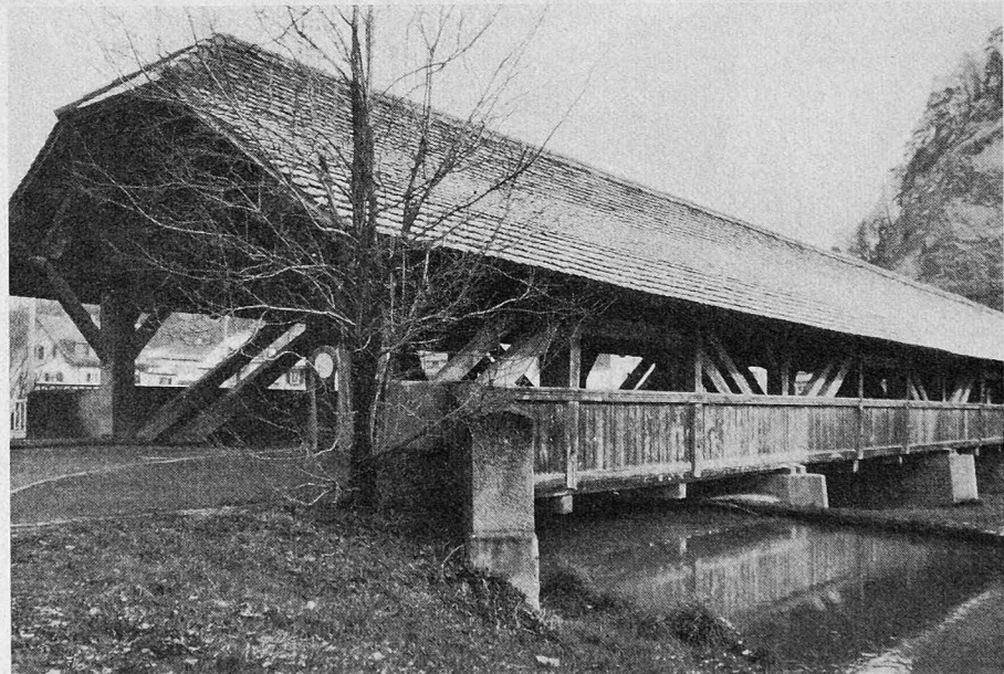
Bild 9. Wynigen (1764): Zwei parallel laufende, voneinander unabhängige Hängewerke
