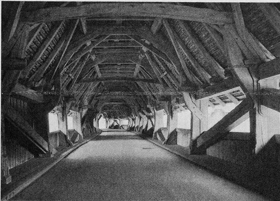
Bild 12. Neubrücke, Bern (1532): Erster Dachbinder mit Zugholz und Druckbügen in der mittleren Rahmenecke, folgender Binder mit Zughügen und klaffendem Versatz
