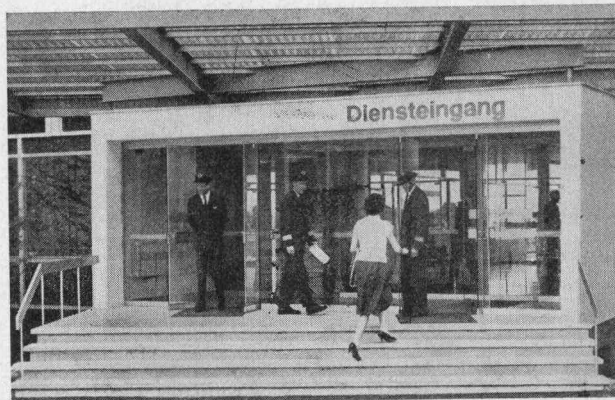
TORMAX im Flughafen Zürich-Kloten: acht Ganzglas-Doppeltüren, angetrieben durch TORMAX, Steuerung durch Kontaktteppiche.
