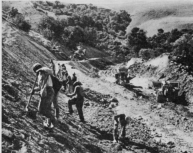
Bau der Nationalstrasse durch die Crocodile Poort zwischen Nelspruit und Kapmuiden. Die unwegsame Schlucht bot dem Strassenbau erhebliche Schwierigkeiten
