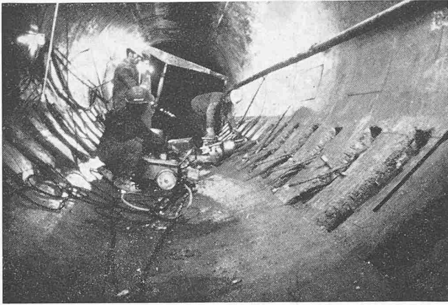
Bild 9. Vorgespannte Betonauskleidung als Sanierung des 11,4 km langen Druckstollens des Kraftwerkes Piastra-Andonno, Italien
