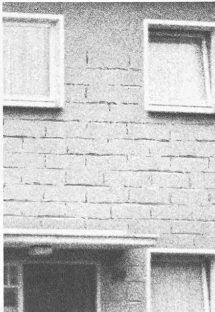
Bild 3. Spannungsrisse
