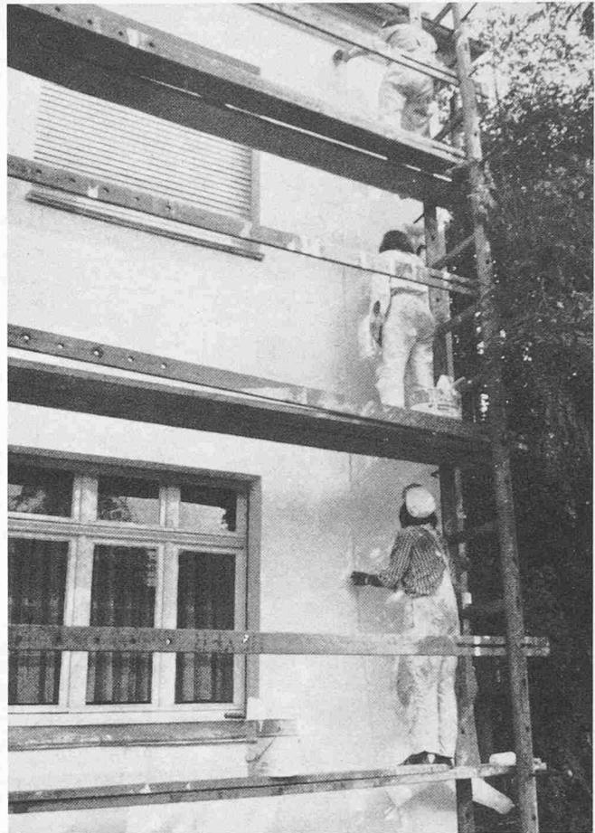
Bild 6. Einlegen des Elastic-Gewebes in den Armierungskleber
