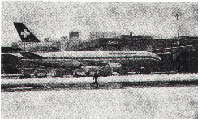
Im Flughafen Kloten werden 16 000 m 2 Standplätze mit einer MULTIBETON-Bodenheizung schnee- und eisfrei gehalten.
