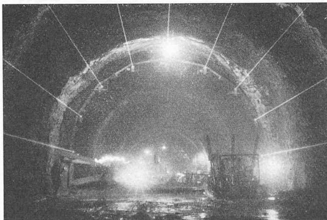
Bild 2. Mit Blick Richtung Südportal ist auf dem östlichen Gleis der Betonzug für die Herstellung des Gewölbebetons sichtbar. Von links werden die Zuschlagsstoffe und der Zement herangebracht und mit der Förderanlage in die entsprechenden Silos verteilt. Dahinter befindet sich der Zwangsmischer, welcher den fertigen Beton direkt in die Pumpe abgibt. Im Vordergrund die mit Folien isolierte Tunnelwand
